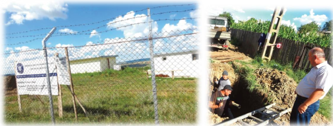
Foto: Lucrări la sistemul de apă al comunei Țibana – Imagini puse la dispoziție de Primărie
