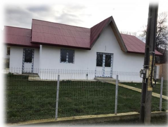
Foto puse la dispoziție de Primărie: Școala Oproaia din comuna Țibana
